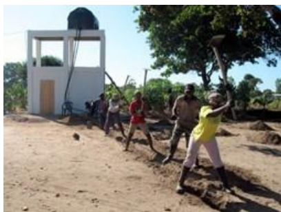
Vandtårnet er færdigt. Nu er der altid vand. Rørene føres ind. MAR 11
